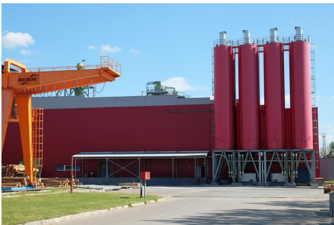
Склад хранения цемента
